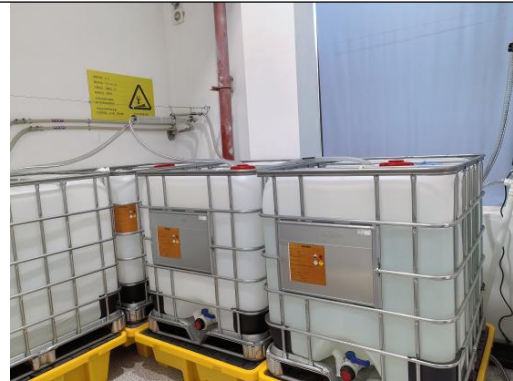
危废仓库内部照片
