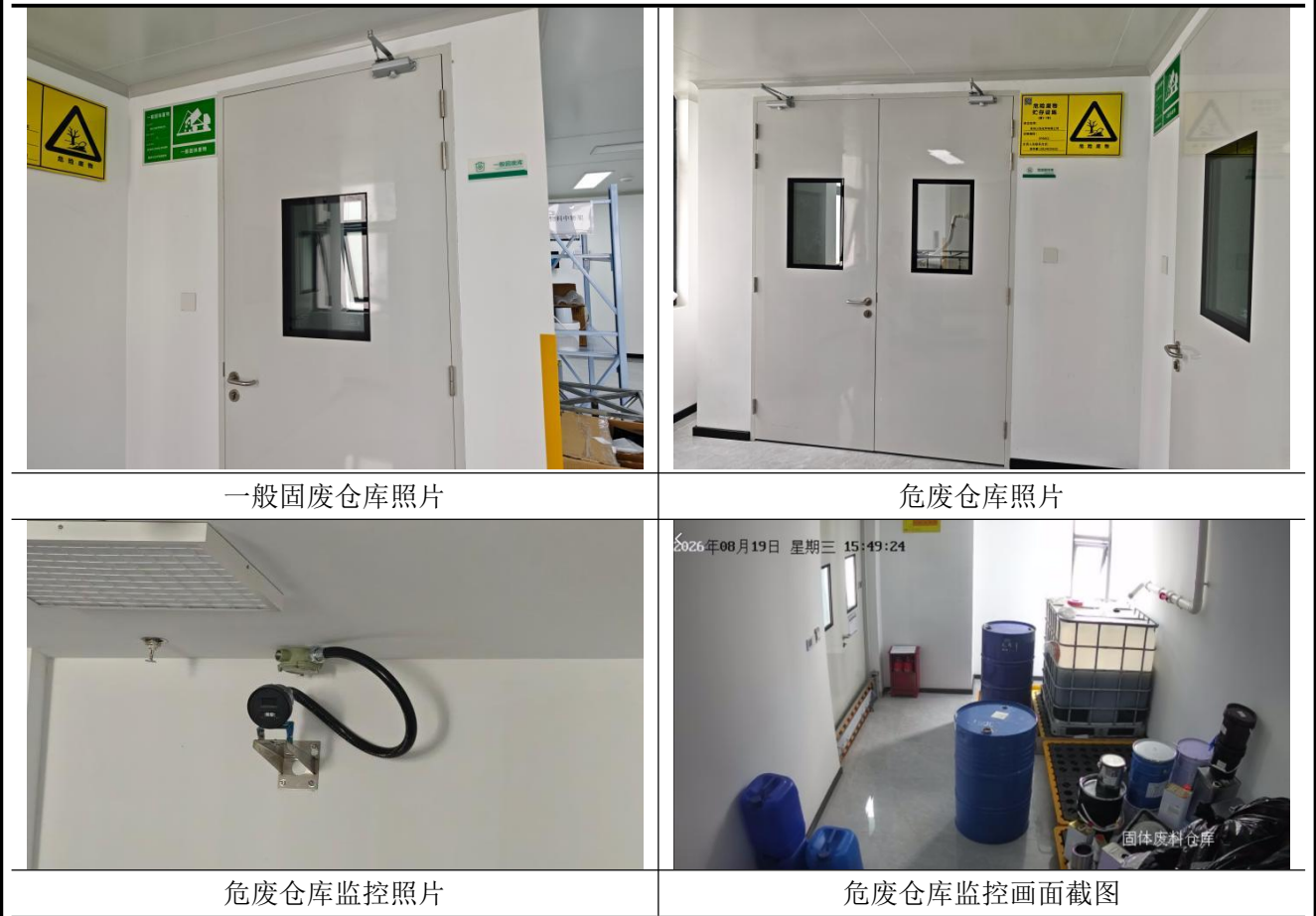
图 3-1 本项目危废仓库、一般固废仓库建设情况图
